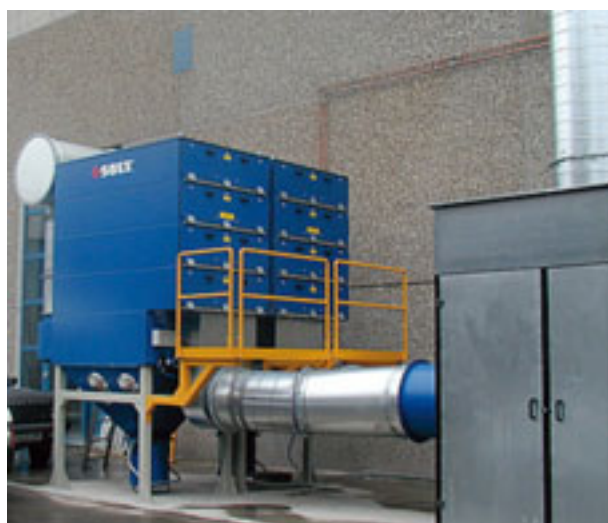
Stoffilterkasten (Bron SULT Staub- und Lufttechnik)
